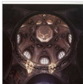
Fig.21. Coupole à nervures entrecroisées.
